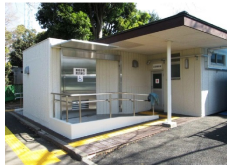
車いす用更衣室 新設
