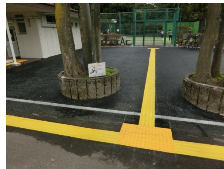
段差解消・点字敷設
