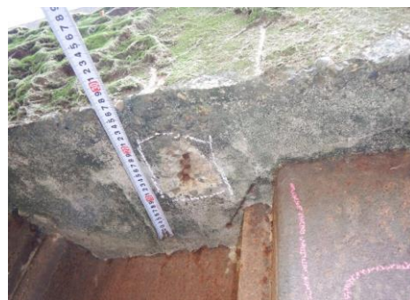
右岸（川表側）の調査状況
