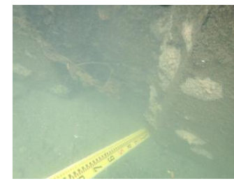
根入れ状況調査
