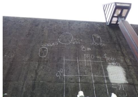
左岸（川裏側）の調査状況
