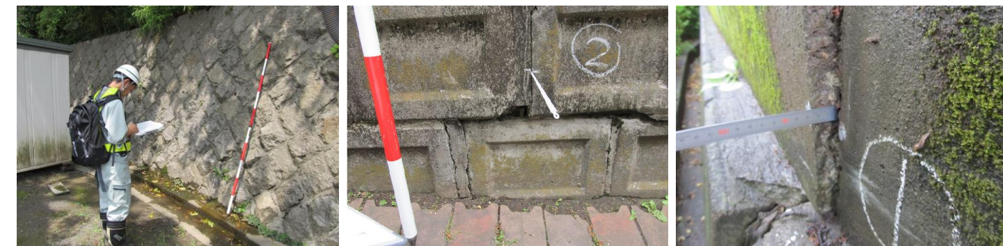
点検作業状況
