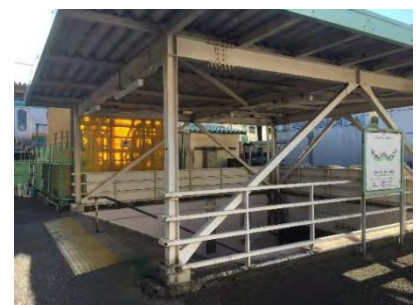
写真 タイムカプセル平成ロードの入口
