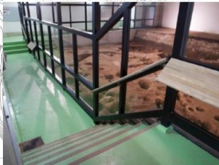
写真8: 北貝塚住居跡群観覧施設内部
