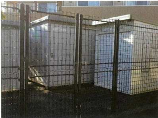
⑦ 防災倉庫
