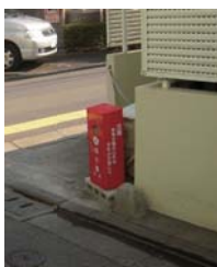
街路設置消火器
