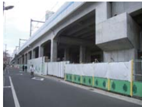
【整備中の高架下と側道】
