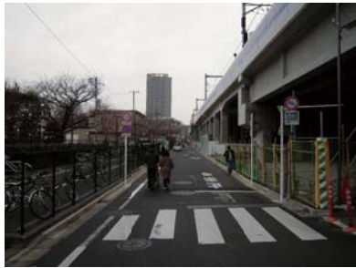
【鉄道の立体交差化と合わせた周辺道路整備】 (西武池袋線石神井公園駅周辺)
