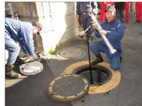
■消火栓の鉄蓋を開け、ドライバーを放水弁に、スタンドパイプを吐水弁に設置
