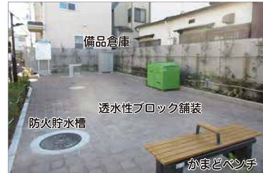
■防火貯水槽 (20t) を設置し、透水性ブロック舗装を敷設
