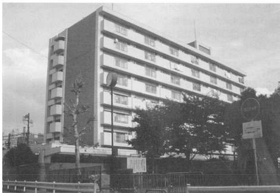
区営東田端二丁目アパート(平成11年4月)
