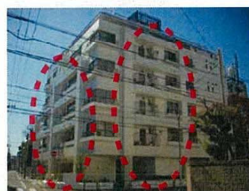
アウトフレーム工法による耐震補強
