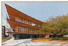
先導的建築物例(木造による耐火建築物・事務所)
