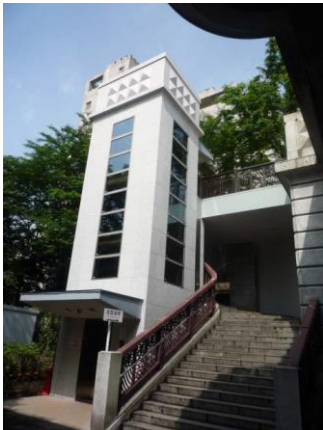
音無橋脇昇降施設（エレベーター）
