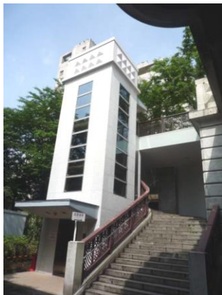
音無橋脇昇降施設（エレベーター）
