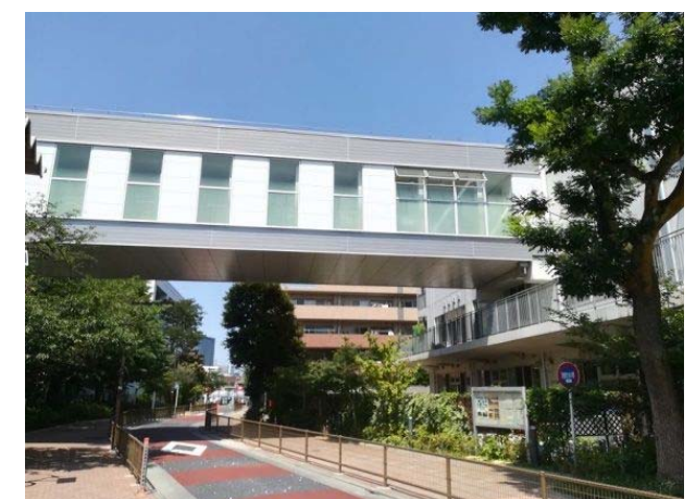
④2つの棟を繋ぐ渡り廊下
