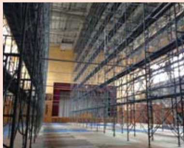
大規模な足場を組んで現状を調査
