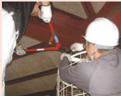
すべての照明器具をワイヤーで固定
