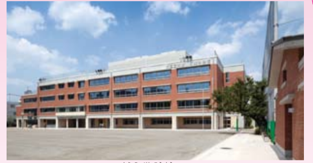
滝野川紅葉中学校 (平成25年9月完成)
