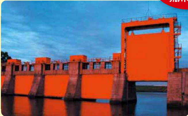
夕焼けに照らされた旧岩淵水門 提供：国土交通省 荒川下流河川事務所 日中は水面がキラキラと輝く荒川の景色を楽しめますが、日の出や夕焼けに照らされた景色もこのコースの魅力のひとつです。
