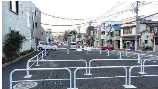
整備が進む補助83号線
