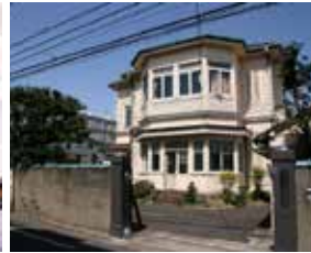
黒田機器(株)の建物
