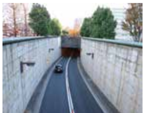
赤羽台トンネル
