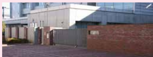
陸軍の工場で作られていたレンガを利用したレンガ塀
